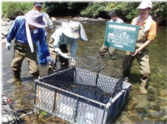
石を詰めるネット組み作業である。外枠を組み、中にネットを組み立てている。
