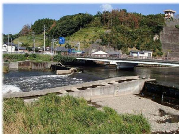
設置場所には、水位調整が可能な井堰があり、作業時には水位を下げる可以降低。
