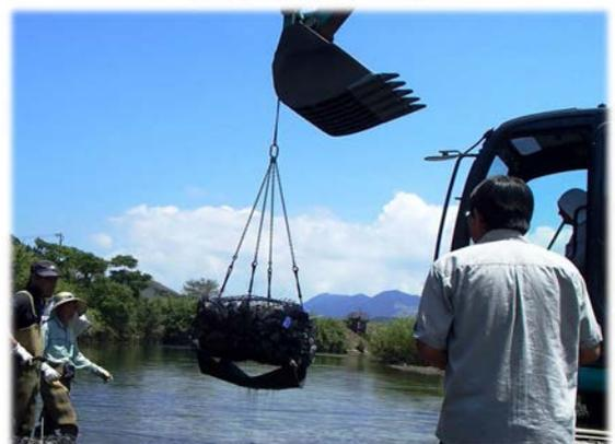
石倉カゴを重機で移動し設置する作業である。
