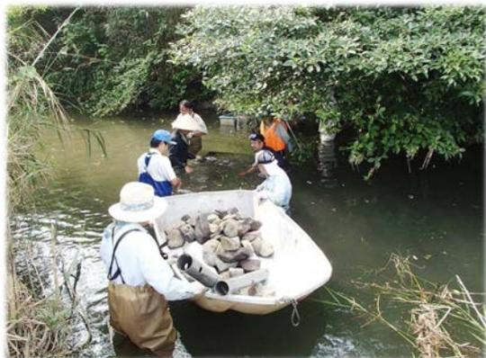
水深がある場所での設置は重機が入れないので、手作業で設置した。
