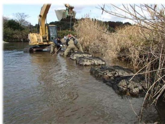
平成 25 年度の石倉カゴ設置状況である。河岸近くに設置したため、現在は土砂に埋もれている。
