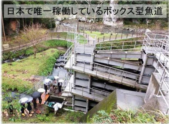
「こせの滝魚道」は落差約 7m で、日本で唯一稼働しているボックス型魚道である。
