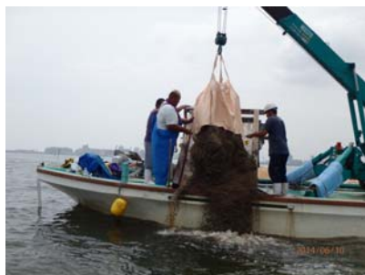
客土(H26年度は約512m 3 を投入)
