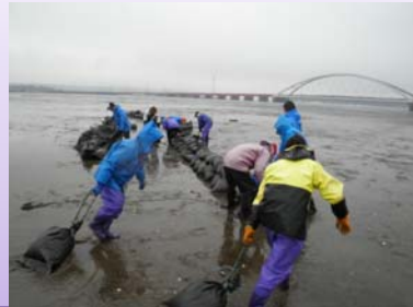
土嚢の積み上げの様子
